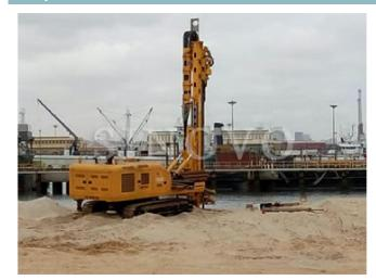
Рабочая площадка в Анголе Глубина бурения - 18 м. Диаметр скважины - 200 мм. Толщина нижней прослойки - 4 м.
