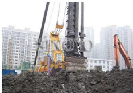
Наше электрогидравлическое бороздовое оборудование для забивки свай, как предполагает его название, является машиной запускаемой электрогидравлической системой управления. Может быть оснащено гидравлическим вибратором, гидравлическим молотом, DTH, устройством шнека и т.д. При различных методах строительства могут быть реализованы модульные комбинации, такие, как «ОАО», «СМЗ», «CFG», «CFA», «DRA» и «PRD».
